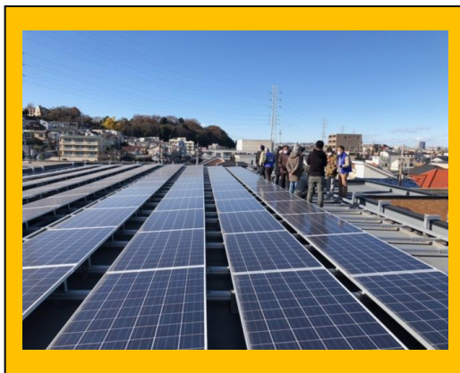
太陽光パネル219枚。強風にも耐えられるよう、当法人独自の設計による工法を採用。
