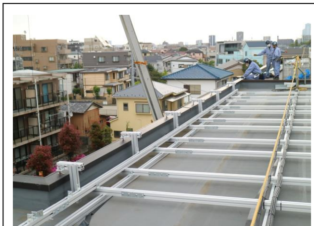
「発電所 4 号機」 架台設置工事の様子
