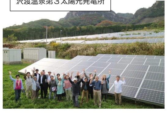
沢渡温泉第3太陽光発電所
