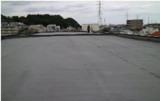
▲建設予定のアパート屋上
